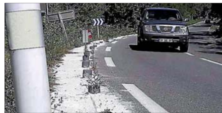
■ La semelle de béton et les trous de réservation.
